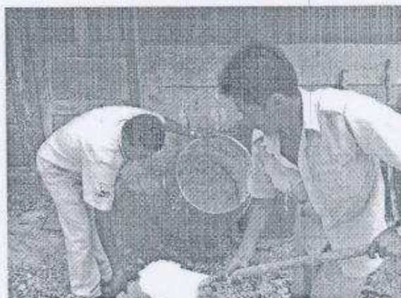
Foto 11. Preparación de mezcla para trabajos de conservación
